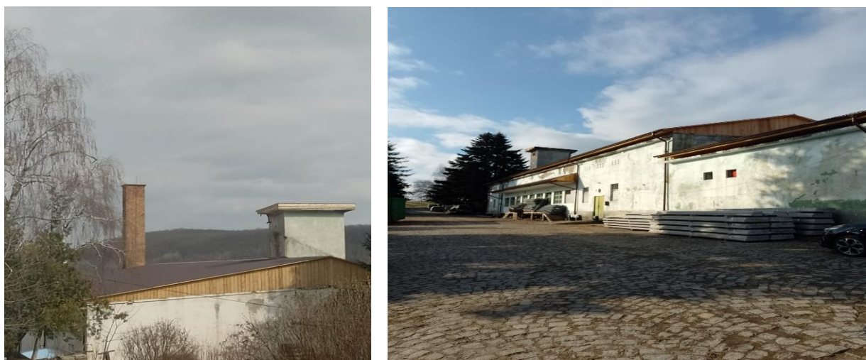
Figura 29. Aspecte din exteriorul silozului de fructe - acoperiș nou
