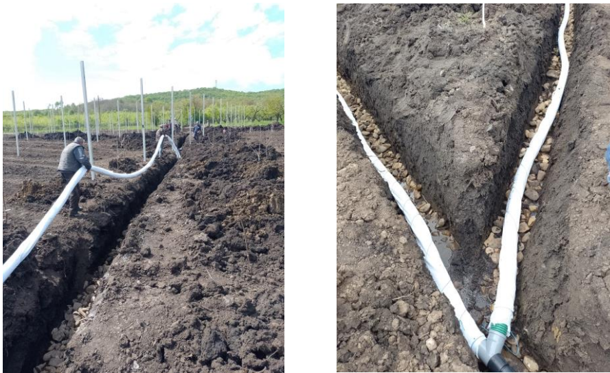
Figura 28. Eliminarea excesului de umiditate din lotul demonstrativ de cireș prin realizarea de drenaje
