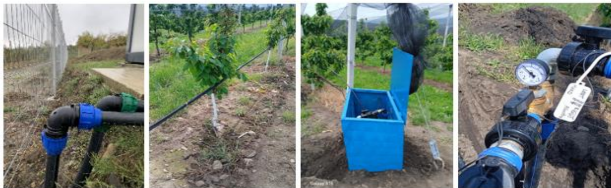
Figura 35. Instalarea sistemului de fertirigare Irritec-Shaker Pro și punerea sub presiune a sistemului la P=2,0 bari la soiurile timpurii (Merchant, Bellise, Bigareau Burlat / GiSeIA 5) (sursa:original)
