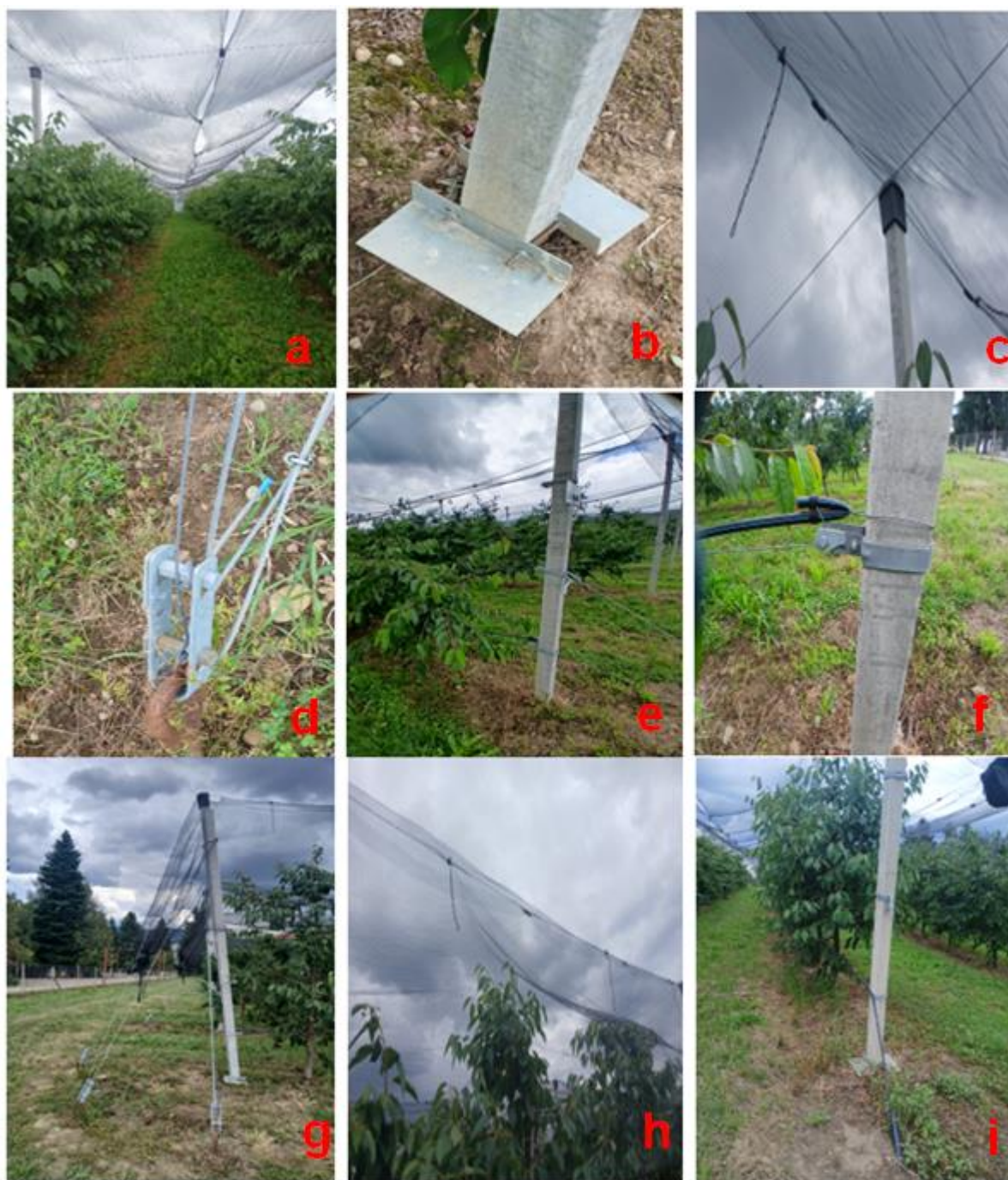
Figura 50. Sistemul antigrindină (plasă antigrindină (a), sistem plăci antiscufundare (b), capișoane capăt (c), sistem de blocare funie superzincat (d), funii de strângere plasă (e), cleme cu suruburi ptr strângere funie(f), stâlp de capăt cu 3 funii de ancorare, lanțuri de strângere plasă pe culme și plachete de prindere plasă (h),sistem de prindere sârme complet echipat (i) (sursa:original)
