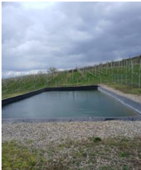
Figura 28. Bazin din ciment căptușit cu folie EPDM, volum 800 mc (sursa:original)
