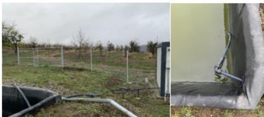
Figura 29. Sistemul de alimentare cu sorb din bazinul de stocare (sursa:original)
