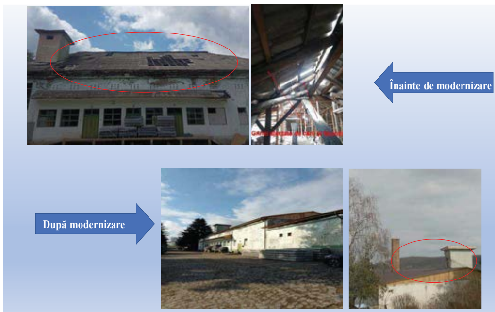
Figura 19. Aspecte cu acoperisul depozitului de fructe - înainte și după modernizare
