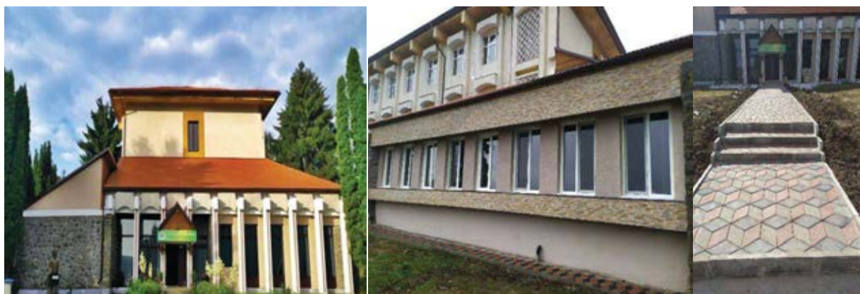
Figura 12. Reabilitarea parțială a fațadelor sediului SCDP Bistrița și reconstrucția aleilor de intrare și zonele marginale
