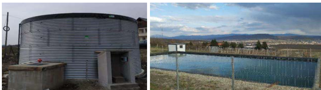
Figura 18. Bazinul suprateran (stânga) și subteran (dreapta) de stocare a apei din drenuri
