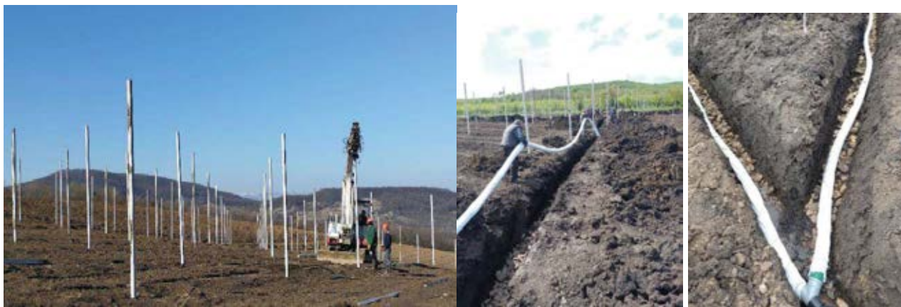
Figura 8. Aspecte din activitatea de înființare de loturi experimentale cu tehnologii moderne și realizarea de drenuri
